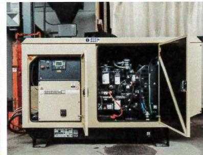
*Die Umsetzung des Projekts erforderte ein Aggregat, das nicht nur im Netzersatzbetrieb, sondern auch netzparallel einsetzbar ist.*
